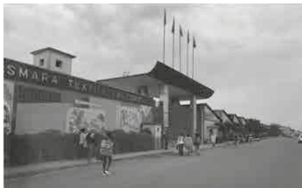
Figura 1: ingresso Fabbrica Za-Er Asmara
